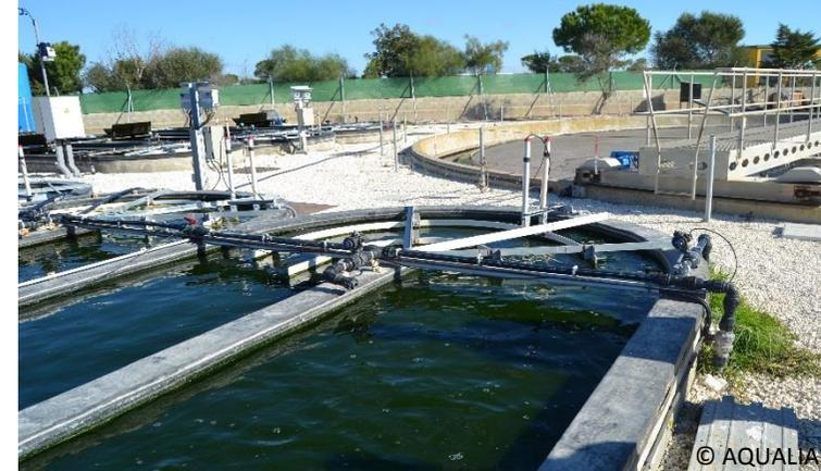
Sistemas de algas de alta carga en Chiclana para el tratamiento de aguas residuales y la producción de bio-plásticos operadas por AQUALIA
